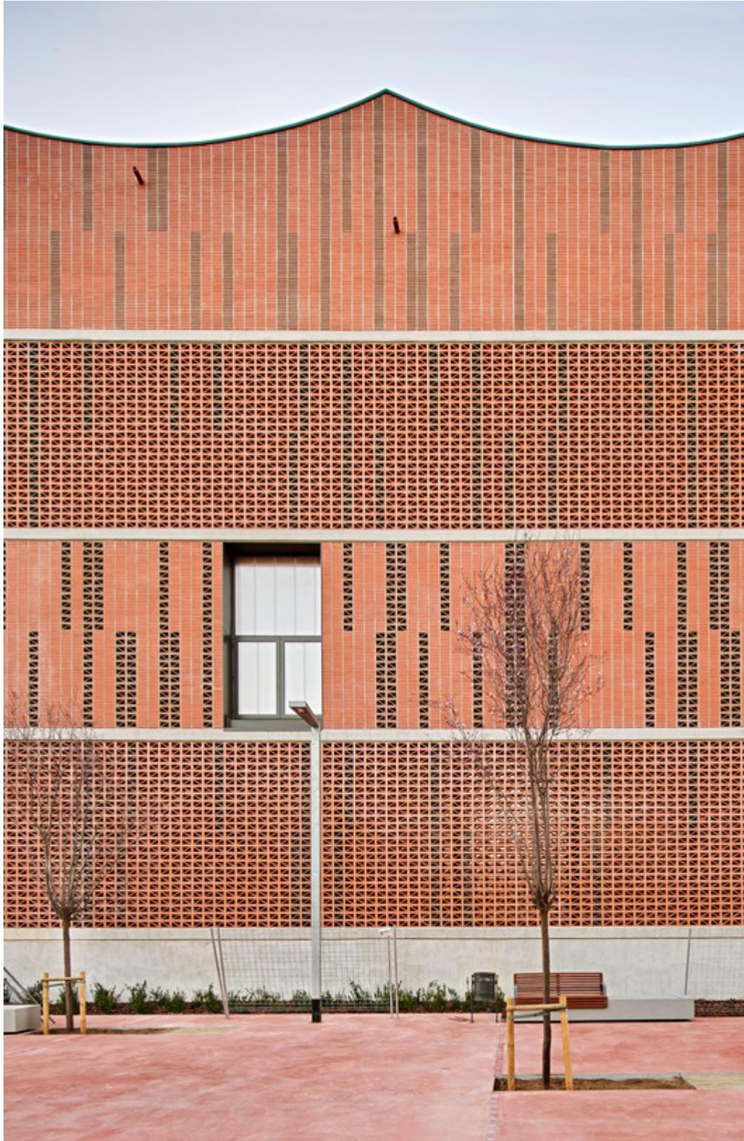
最终，Camp del Ferro体育中心半地下部分的建设另一个经过深思熟虑和内在价值证明的结果是能源消耗和生态环境的改善。一方面，随着表皮暴露表面减少，建筑整体热惯性随之增加。另一方面，通过陶瓷窗框和植物种植保护的大型玻璃开孔和天窗，可以避免自然光直射，使得球场免受阳光直射。
