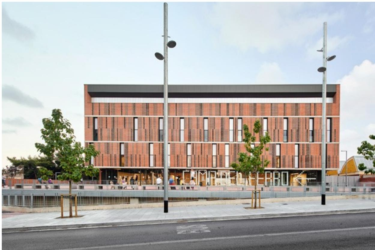
Para lograr encajar el amplio programa funcional en el solar de reducidas dimensiones, los arquitectos han optado por **soterrar una parte importante** del complejo polideportivo. El cuidado trabajo en sección permite asegurar en todo momento la buena iluminación, la ventilación natural así como, el cómodo acceso o evacuación de las zonas inferiores.
