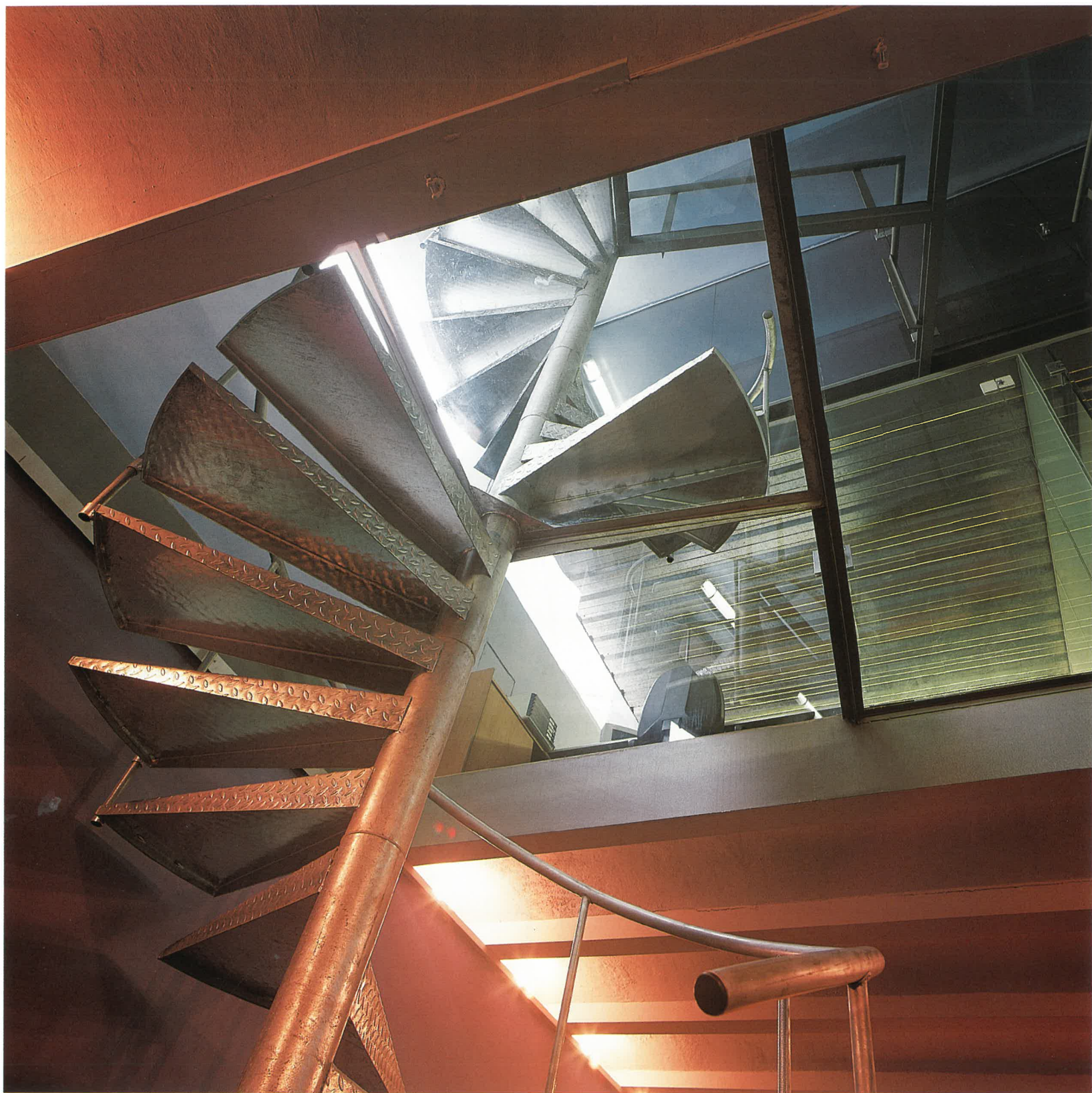
14— La escalera de caracol de comunicación vertical en su descenso hasta la planta sótano.
