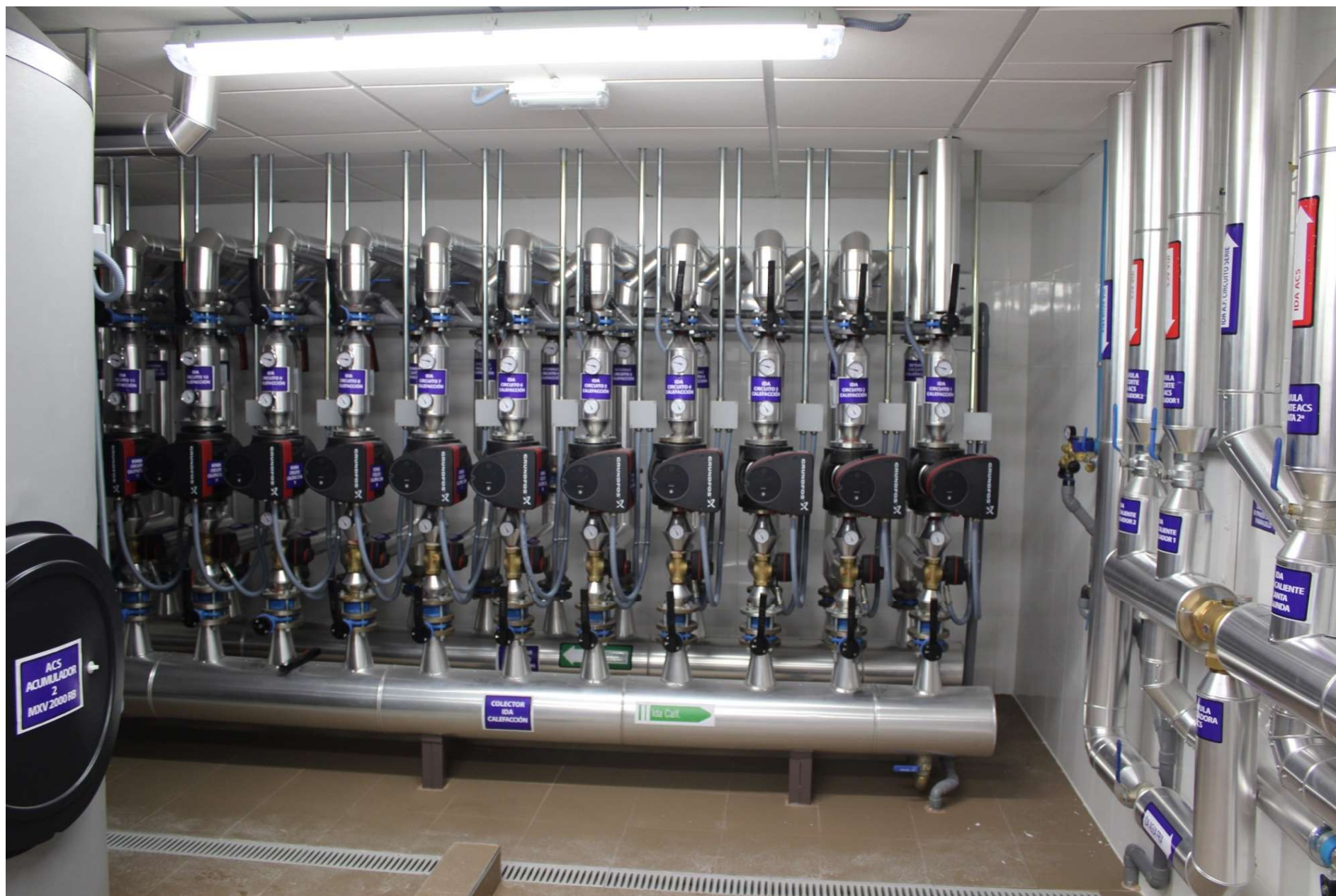
CIRCUITS D'AIGUA / CALOR / FRED / SIMULTANIS 4 TUBS
