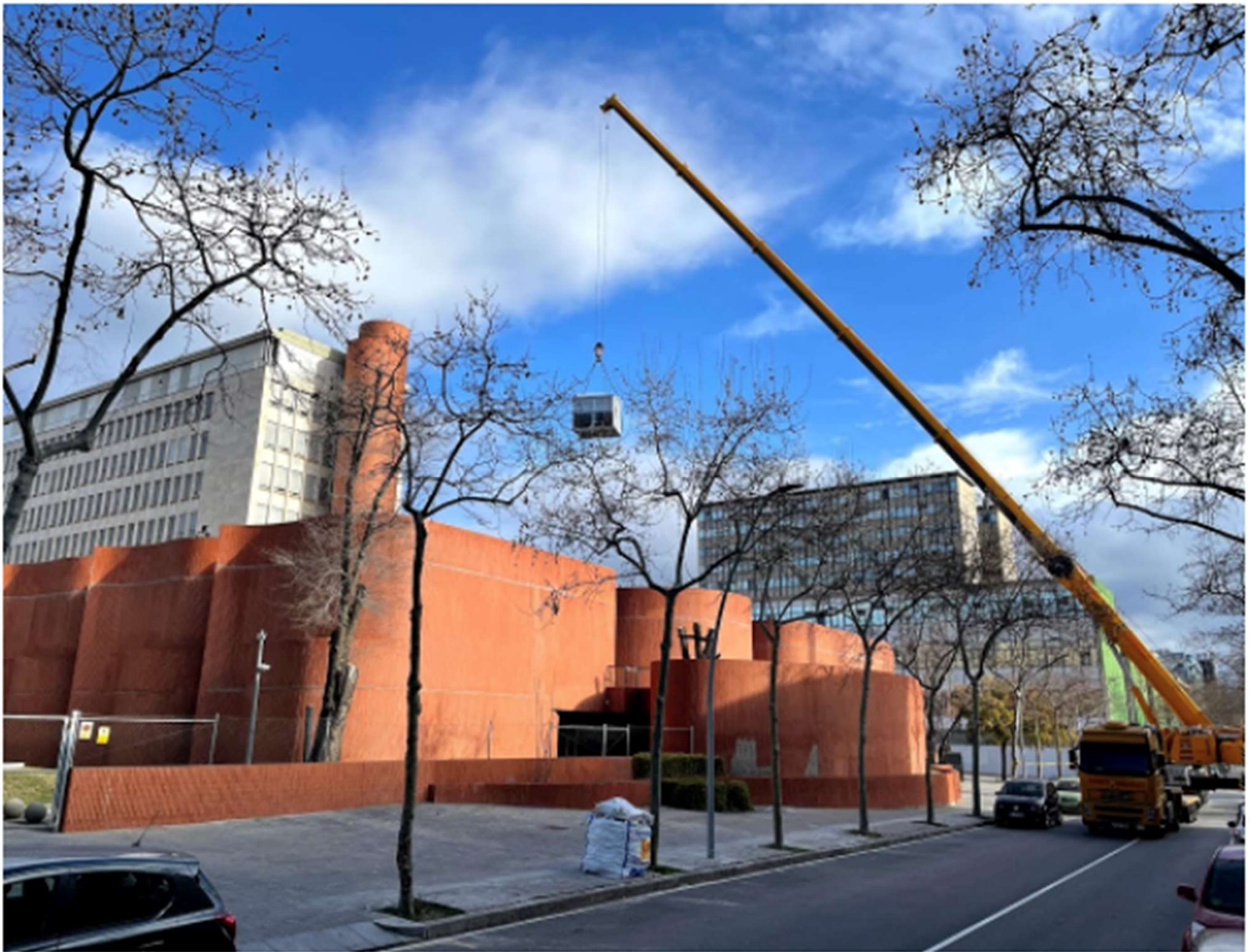
Instal·laci3n de las Unidades de Ventilaci3n en el Aulario Coderch | Agosto 2020
