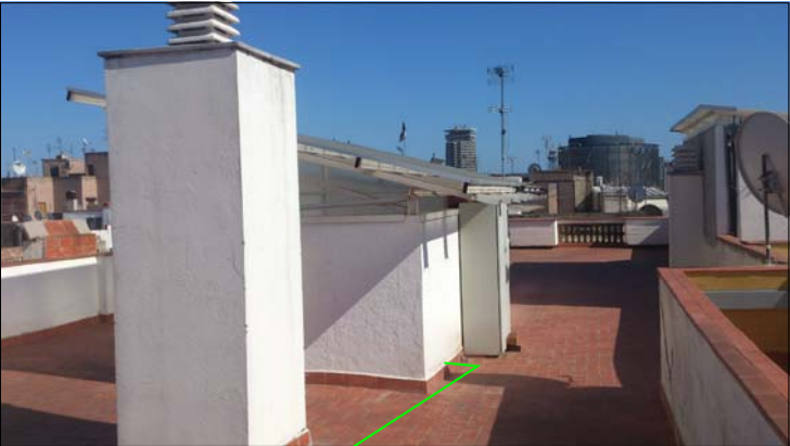
UBICACIÓ UNITAT EXTERIOR DE CLIMA (al. 1380mm x an. 950mm x pr.330mm)
