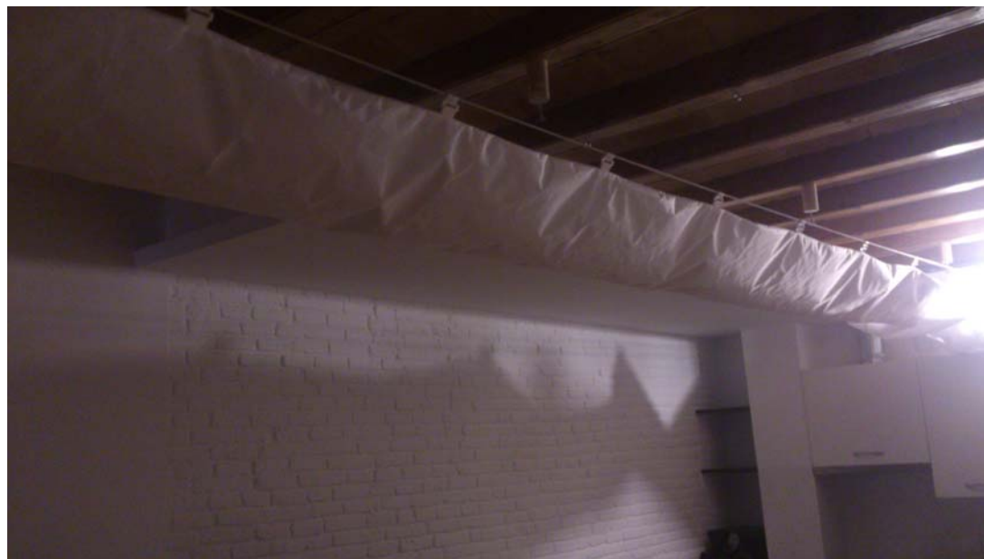
Instal·lació conducte climatització-ventilació
