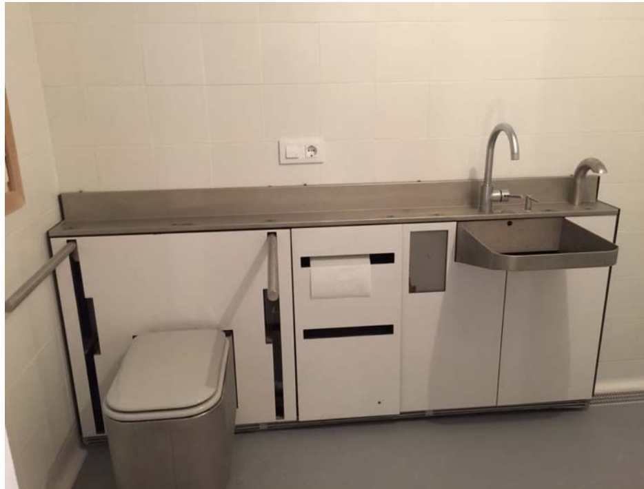
Equip modular TOTS en obra.
